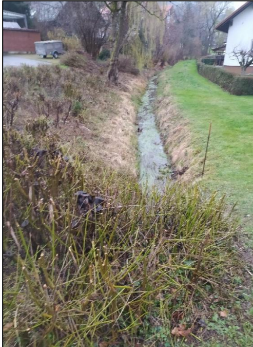
Abb. 2: Der Aulebach Richtung Osten.
