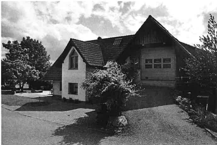
Foto 2: Blick auf die der geplanten Anlage zugewandte Seite des Anwesens "Schillingerbergstraße 21". Links Terrasse und Eingangsbereich, rechts Garage. Blickrichtung gen Süden. Datum: 10.07.2020
