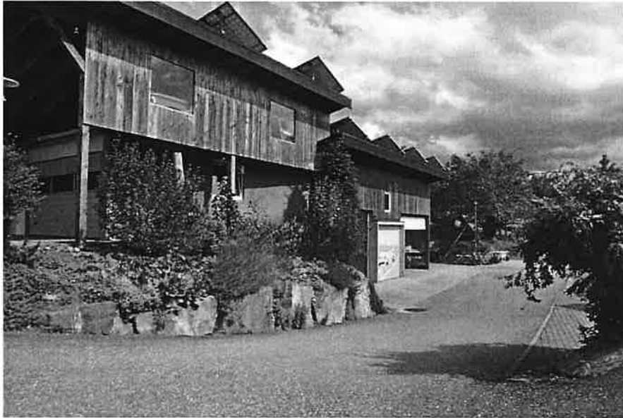
Foto 3: Blick auf Garage/Scheune gegenüber des Eingangsbereichs. Blickrichtung gen Südosten. Datum: 10.07.2020
