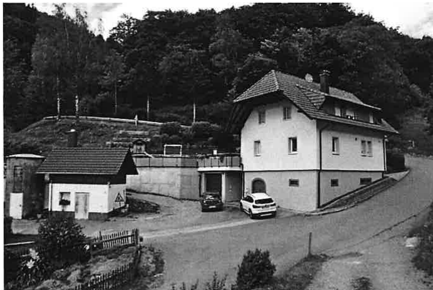
Foto 10: Blick auf das Anwesen "Talstraße 73". Blickrichtung gen Nordosten. Datum: 10.07.2020
