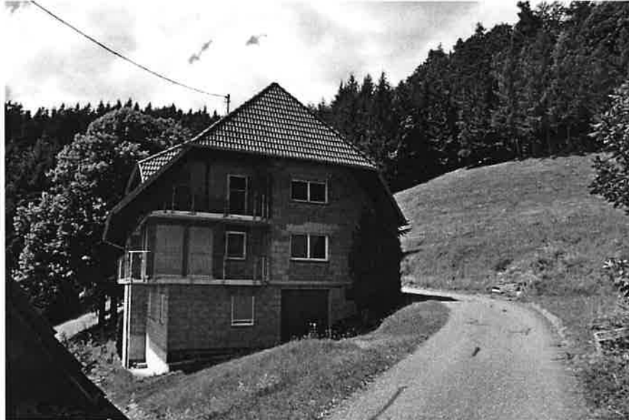
Foto 7: Blick auf die Ostseite des Neubaus. Blickrichtung gen West-Nordwesten. Datum: 10.07.2020
