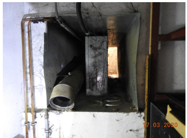
Abbildung 9: Keller mit Lichtschacht, ein toter Igel (17.03.2020)
