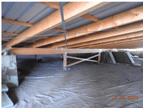
Abbildung 8: Dachstuhl/ keine Spuren (17.03.2020)
