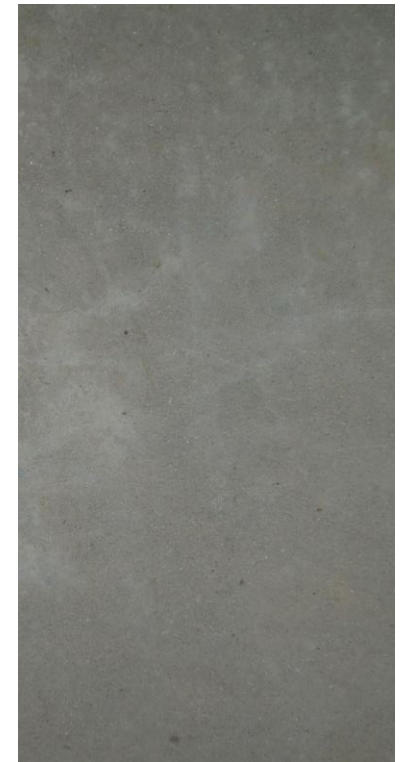
Geschliffener Beton Als Fußboden
