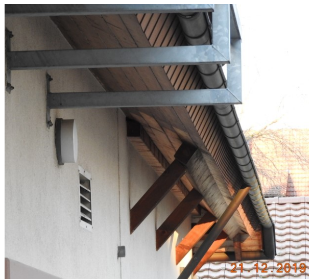
Abbildung 5: keine Spalten bzw. Öffnungen auf der Ostseite des Dachüberhanges (21.12.2019)
